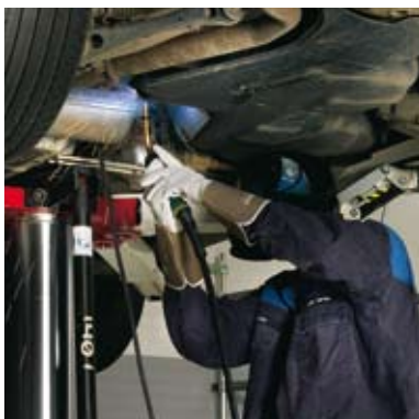
Reparation af udstødningsophæng.
